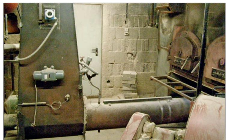
Eine Förderschnecke transportiert eine Mischung aus trockenen Brikettstücken und feuchten Hackschnitzeln in den Kessel.
